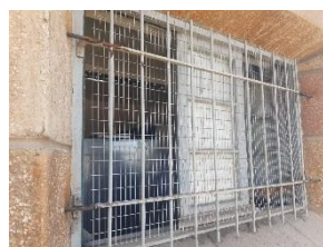
REFUERZO VENTANAS BODEGA CENTRAL DE FARMACIA
