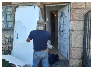
REFUERZO ENTRADA BODEGA CENTRAL DE FARMACIA
