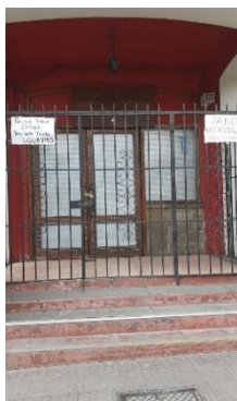
REFUERZO ENTRADA CESFAM DR. EMILIO SCHAFFHAUSER
