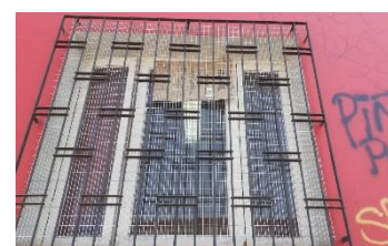
REFUERZO VENTANAS CESFAM DR. EMILIO SCHAFFHAUSER
